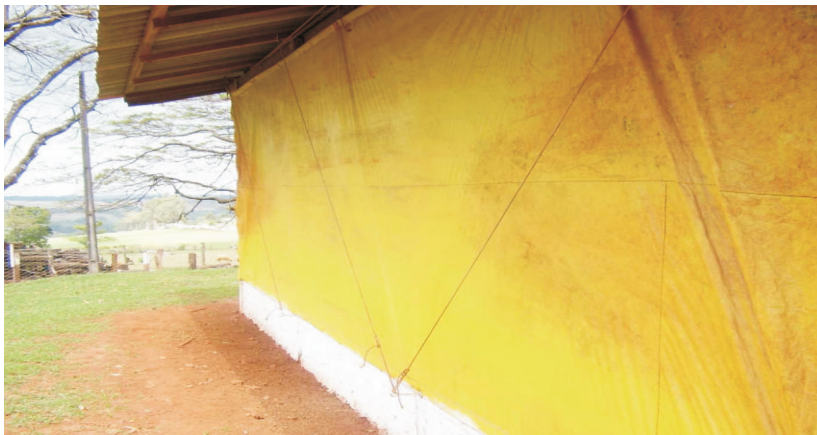
Fig. 3. Corda fixada para manter a cortina próxima à tela. Evita danos e facilita manuseio diário.
